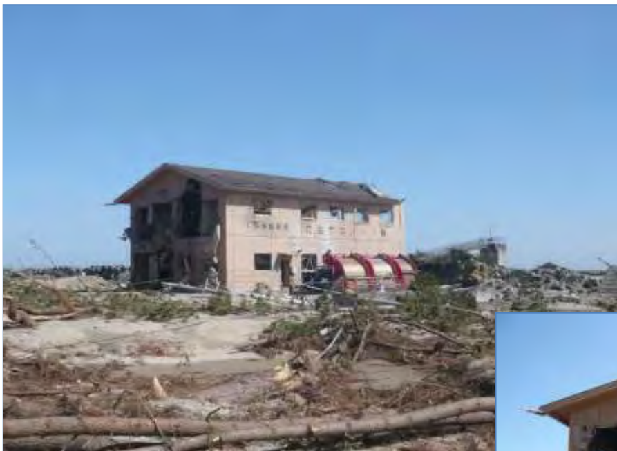
津波により破壊された花笠第2排水機場
