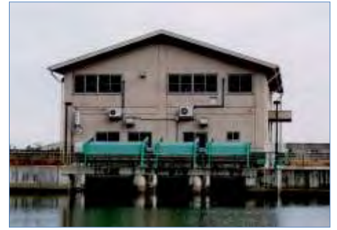
震災前の吉田排水機場・・・①
