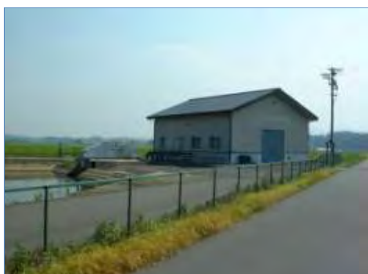
山下第8揚水機場…⑨
